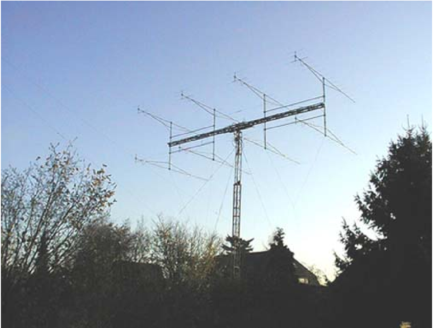
8 x 17 Element Tonna bei DJ6CA 11m Boom ca. 10m hoch
